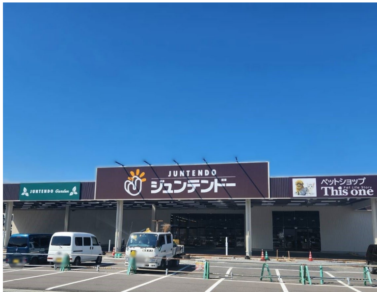
ジュンテンドー萩店（工事中）
